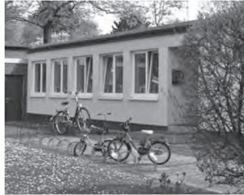
Kinderinsel nach der Sanierung
